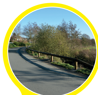
Chemin du Blocu (glissière)
